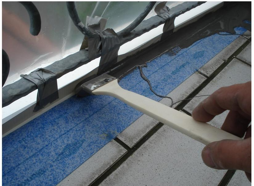
Die Ränder, dort wo die Flüssigfolie weglaufen könnte, müssen unbedingt abgeklebt werden um dieses zu verhindern. Auf Abtropfwinkel müssen Dichtbänder geklebt werden um ein Unterlaufen zu verhindern.
