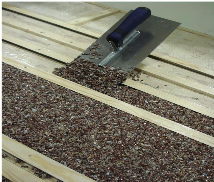
Der prüfende Blick, flach über die Beschichtung zeigt ob einzelne Steinchen nach oben stehen oder auf der Beschichtung liegen.
